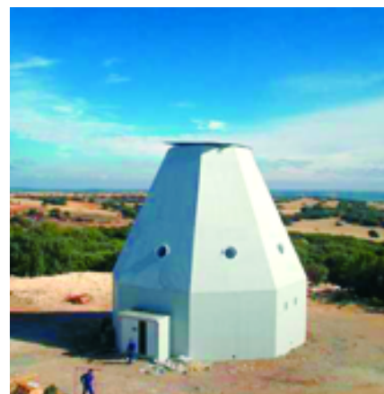
Torre de control.
