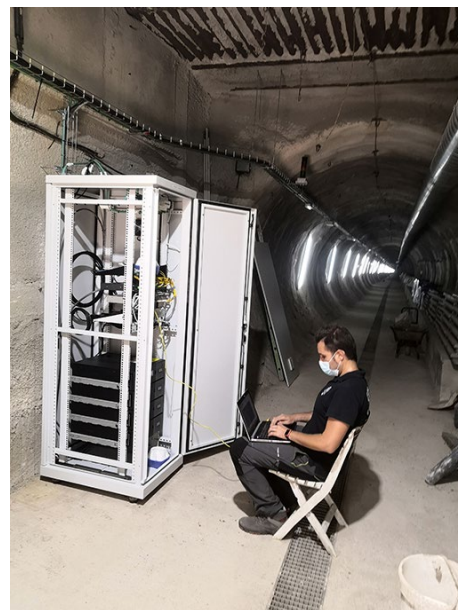
Personal del IGN instalando los equipos de comunicaciones en septiembre de 2020 en la Galería de SECEGSA en Tarifa
